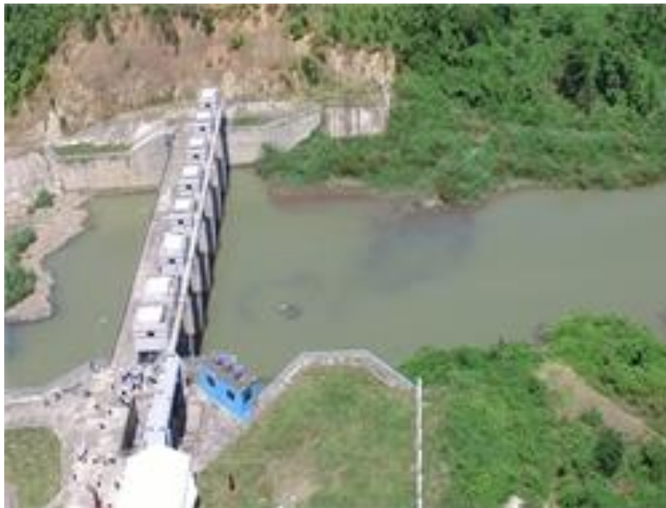
Công trình thủy lợi ở Bình Thuận
