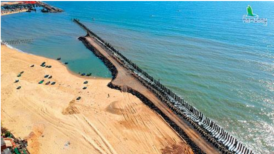
Công trình kè lấn biển 550 m thuộc dự án lấn biển bố trí sắp xếp lại dân cư và chỉnh trang đô thị tại phường Đức Long và xã Tiến Thành do Công ty Trường Phúc Hải làm chủ đầu tư sắp hoàn thành. Nguồn: Báo Bình Thuận Online
